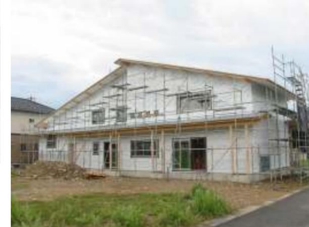
建物の周りに透湿防水シートが貼られました。外観のポリウムがはっきりとわかります。外装が覆われたので、内装の工事（内装下地、配管配線）が同時進行でできるようになります。
