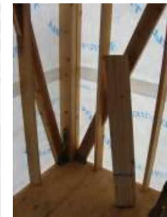
筋交いなどを入れた耐力壁となるところは、柱を引抜く力がかかるので、適切な構造用金物が取り付けられます。
