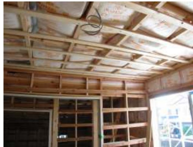
壁や天井に断熱材を入れます。断熱材の室内側には防湿気密シートが貼られていますので、取り付けのときに断熱材を押し込みすぎると、室内の湿気が壁内に侵入してしまいますので適切な施工を心がけます。
