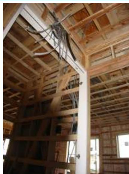
1階食品庫の上部壁に分電盤が取り付けられるため、配線が数多く集められています。
