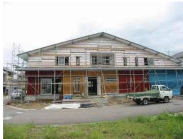
2階外壁の窯業系サイディング張りは縦張りパネルなので、横方向に通気胴縁が取り付けられます。横方向の太い胴縁は付け梁を取り付ける下地となります。
