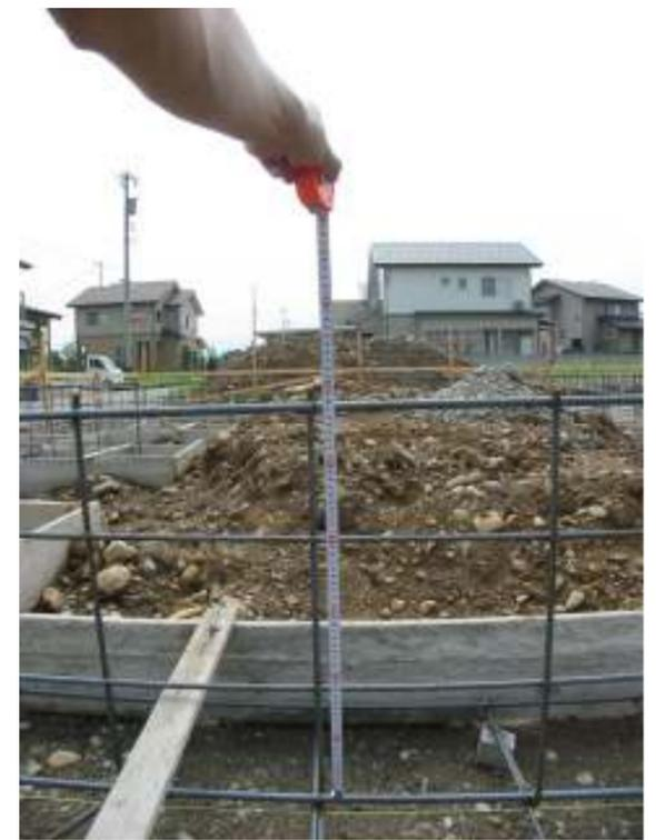
基礎の寸法から鉄筋の高さ・鉄筋径を確認します。
