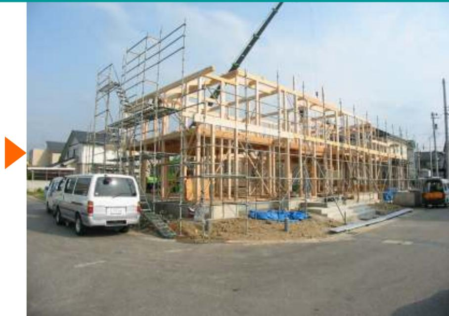
床（プラットフォーム）をつくってから2階の柱を立て、柱の上に小屋梁・妻梁が差し込まれます。
