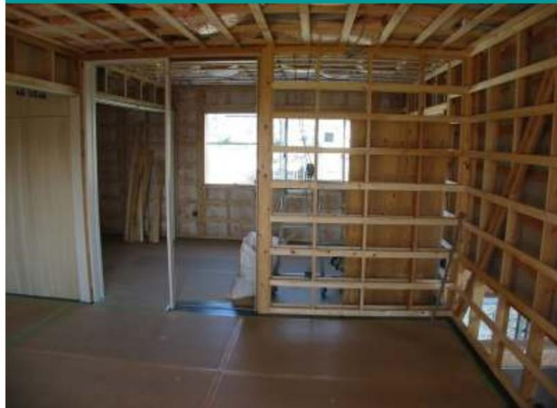
内装壁には間柱や胴縁材を、天井には野縁・野縁受け材で縦横に骨組みをつくります。
