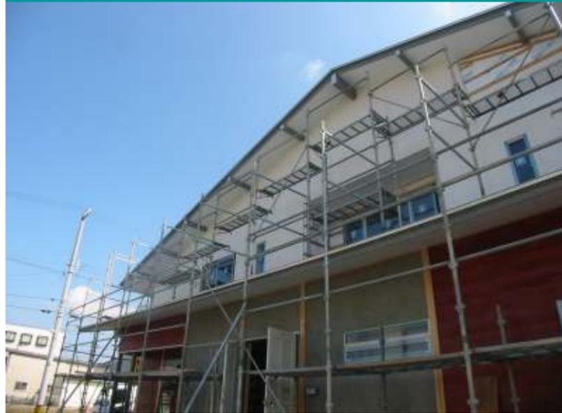
写真右上の外壁部分が、まだサイディングが張られていない状態の写真です。壁の中はこうなっているんです。
