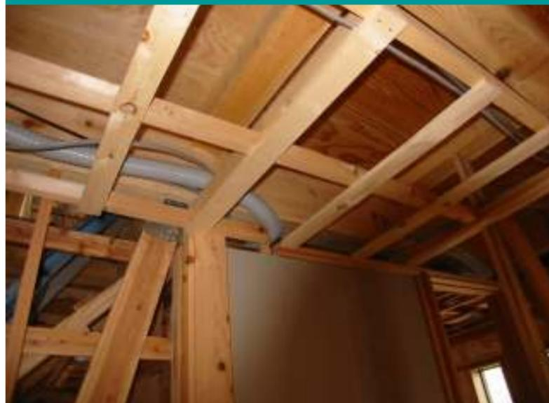
天井部分に換気設備のフレキシブルダクトが設置されました。
