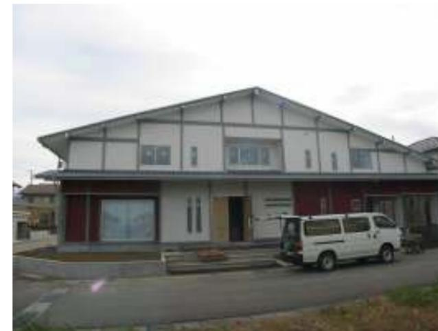
玄関廻りの外壁タイルが張られ、付け柱・付け梁がグレーに塗装されて外壁が仕上がりました。
