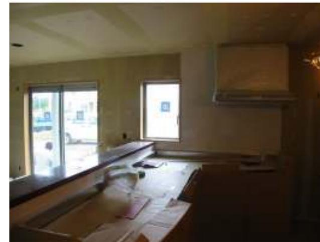
壁や天井にボードが張られます。仕上げのクロスをはる準備としてボードの継ぎ目処理をします。
