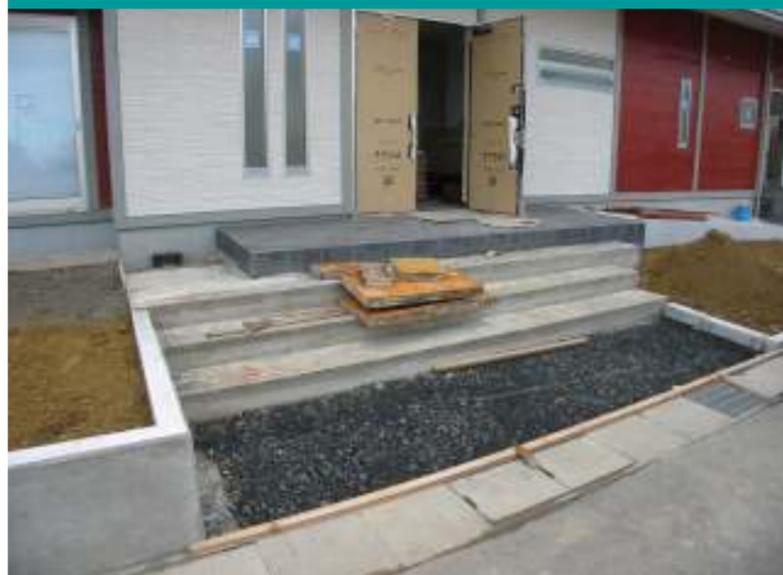
玄関ポーチ部分は、砂利を敷き、コンクリートを打設し金ごてで仕上げます。
