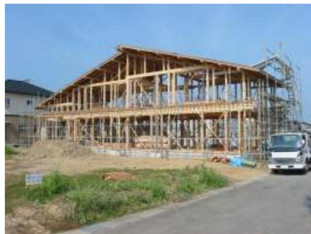
屋根の合板が張られ、屋根に材料が運ばれて、いよいよ屋根工事が始まります。
