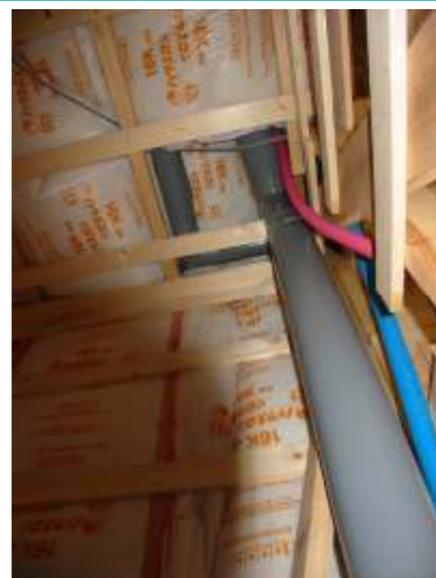
2階トイレの排水たて管の施工をします。
