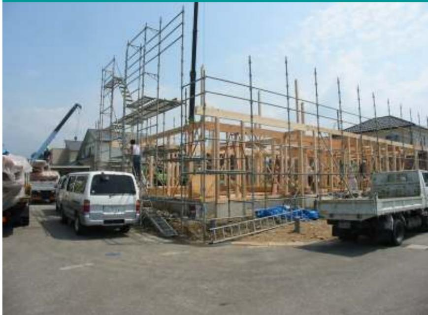
土台に柱が差し込まれ、1階の柱が立ちました。続けて、2階の梁（胴差し・床梁）が取り付けられました。
