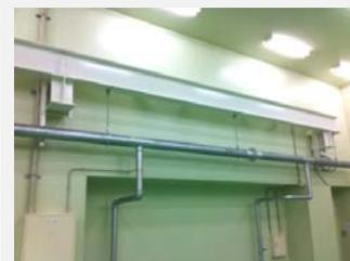
天井クレーンの設置高さをなるべく高く確保するため、天井高さを考慮しながらガイドレールの高さを設定しております。
