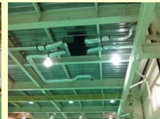
直天井により空調換気機器・ダクトを露出。メンテナンスが容易に行えます。
