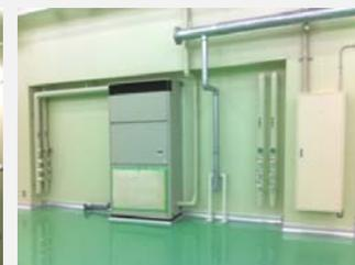
クリーンルーム内のヒートポンプユニット機器は、柱のない壁部分のへこみ空間を利用して設置しました。
